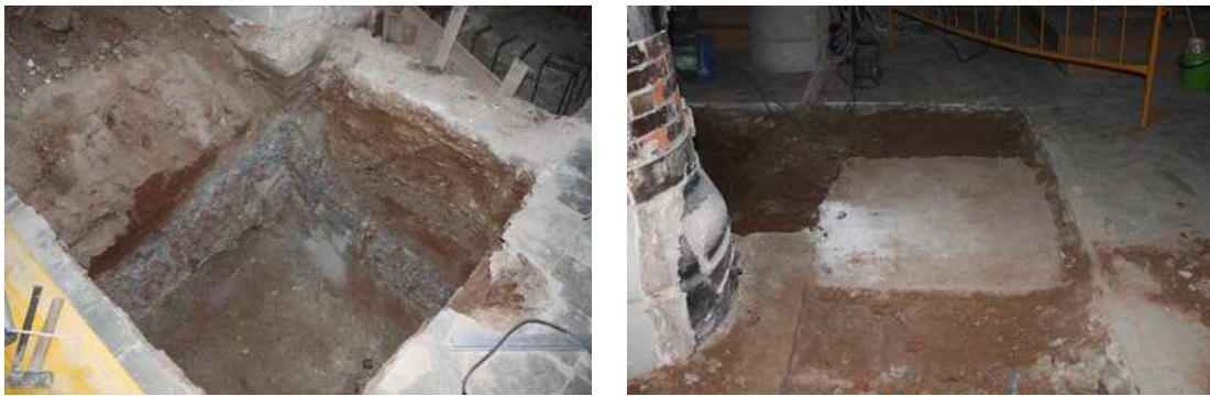
Reforç de les fonamentacions. Imatge de l'esquerre les ríostes d'arc invertit. Imatge de la dreta Bloc de formigó.
