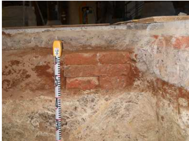
Petita estructura realitzada amb maons col·locats en sec.
