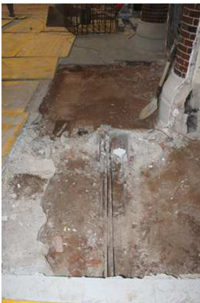
Vista parcial del pilar amb dues les conduccions documentades.
